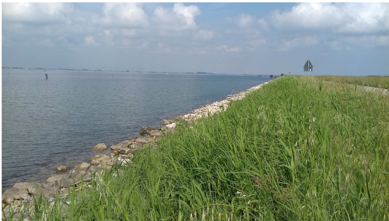
m 70 a valle st. 7 (vista verso banchina in pietrame non interessata da scalzamento)
